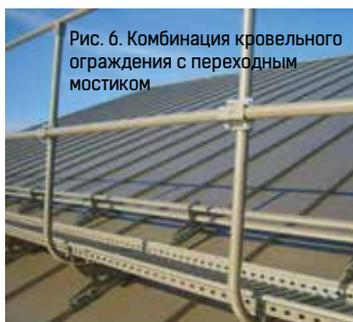
Рис. 6. Комбинация кровельного ограждения с переходным мостиком
