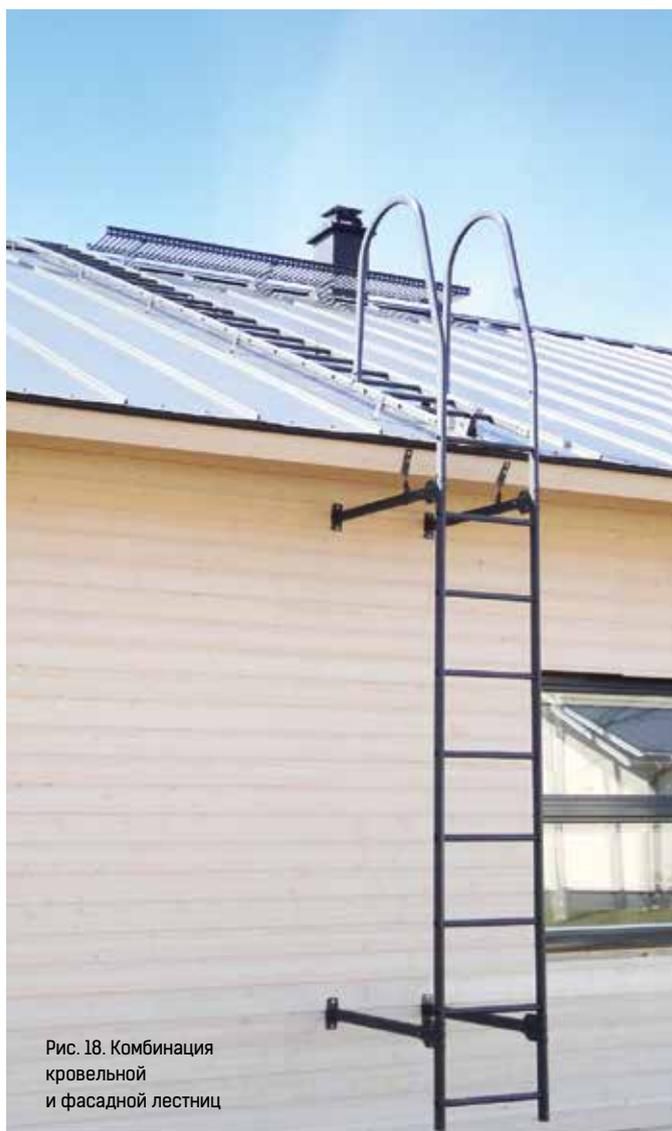
Рис. 18. Комбинация кровельной и фасадной лестниц
