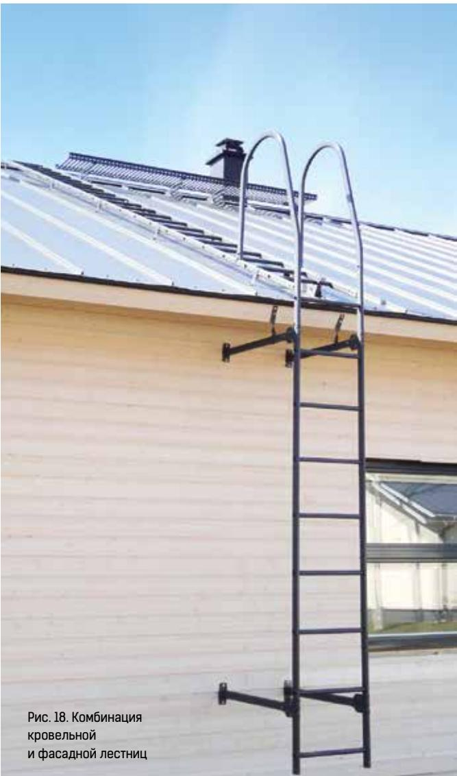
Рис. 18. Комбинация кровельной и фасадной лестниц
