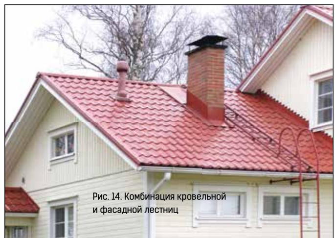
Рис. 14. Комбинация кровельной и фасадной лестниц
