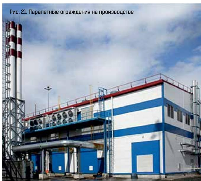
Рис. 21. Парапетные ограждения на производстве
