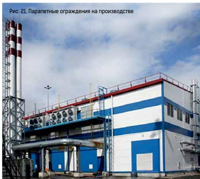
Рис. 21. Парапетные ограждения на производстве
