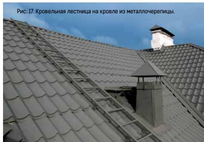
Рис. 17. Кровельная лестница на кровле из металлической черепицы.
